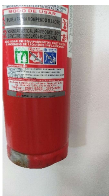
Figura 13 – Pintura da carça com ferrugem ou amassados
